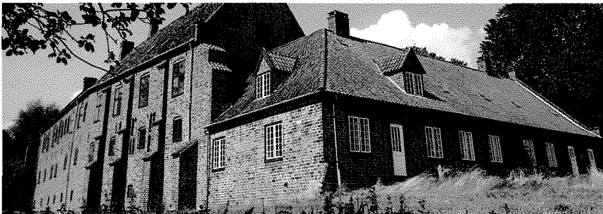
Det nyrenoverede Esrum Kloster.
