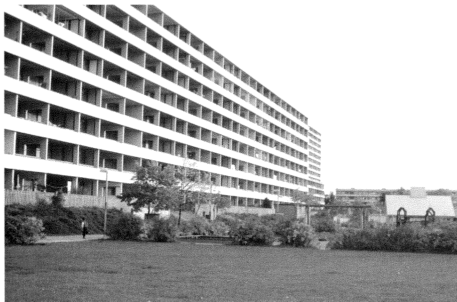
Figur 17. Bolighøjhus i Vollsmose i Odense.
