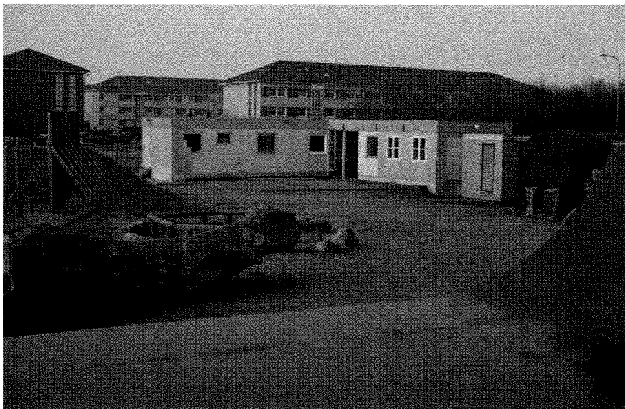
Figur 6. Den åbne legeplads. Bygger'n i Jennumparken.
