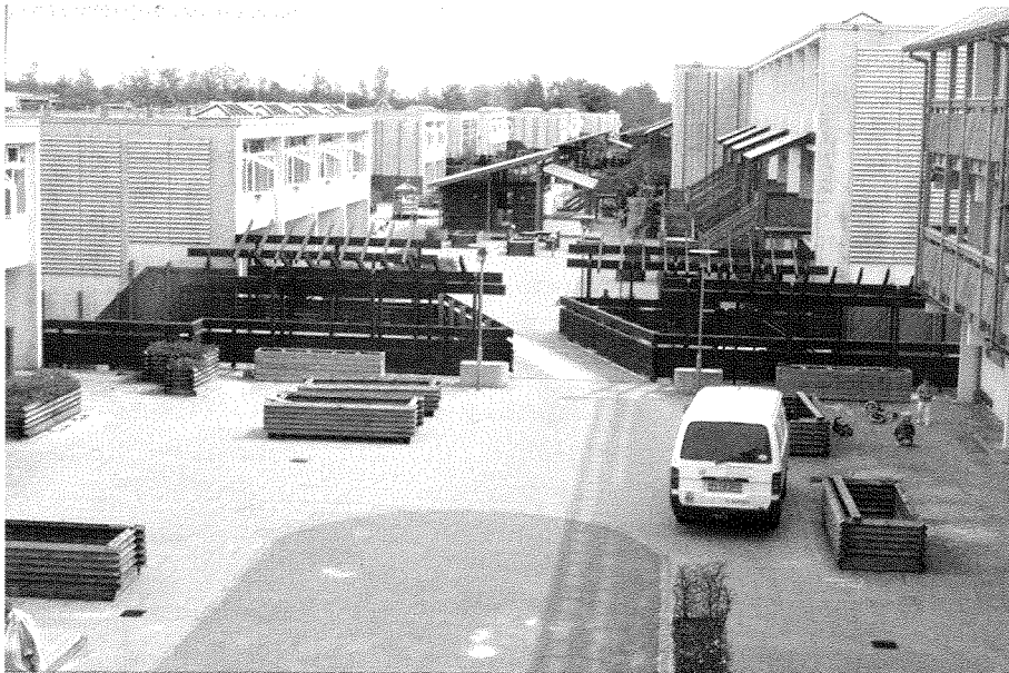
Figur 32. Hovedgaden i det renoverede etageboligområde i Gullestrup.
